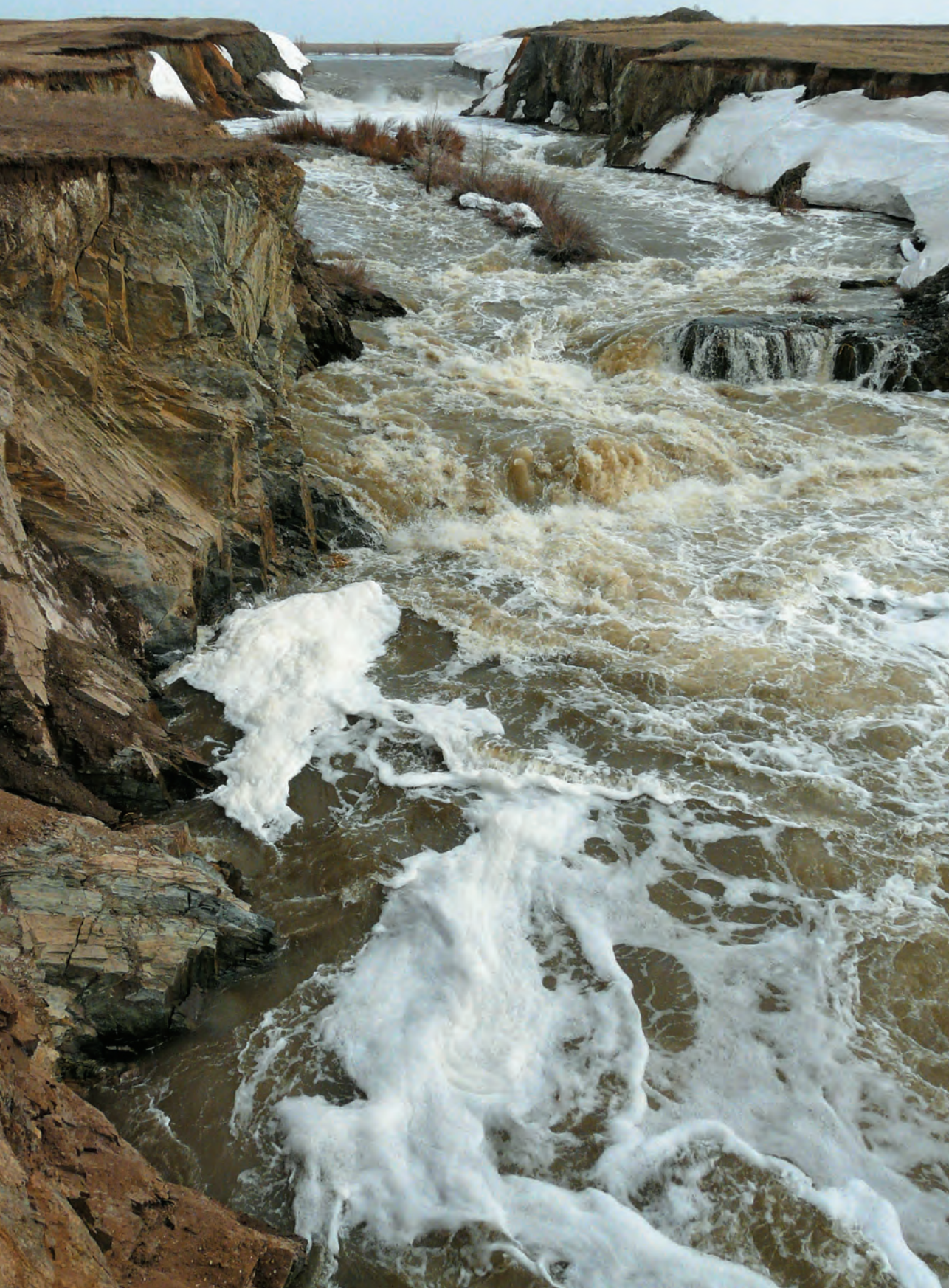
Водосброс Кумакского водохранилища
