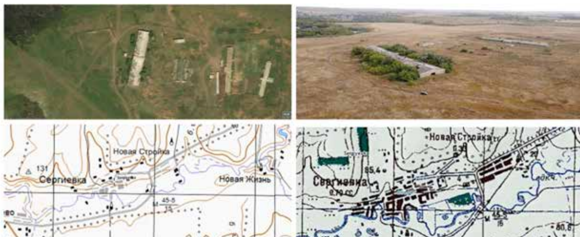
Рисунок 2. Частичное разрушение ферм в селе Сергиевка Первомайского района.
